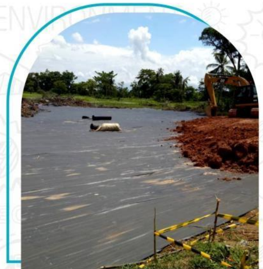
Pemasangan geotextile woven PP
