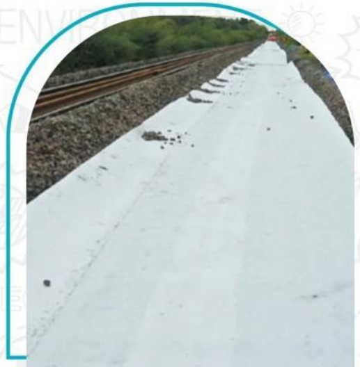
Pemasangan geotextile woven PET
